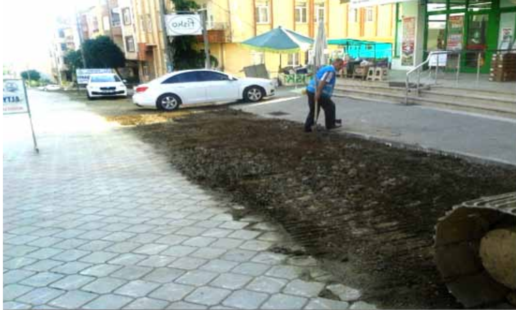
TERFİ HATTI İNŞAATI
