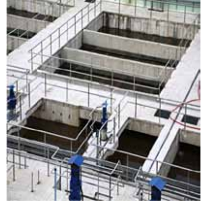
ALTINORDU İÇME SUYU ARITMA TESİSİ
